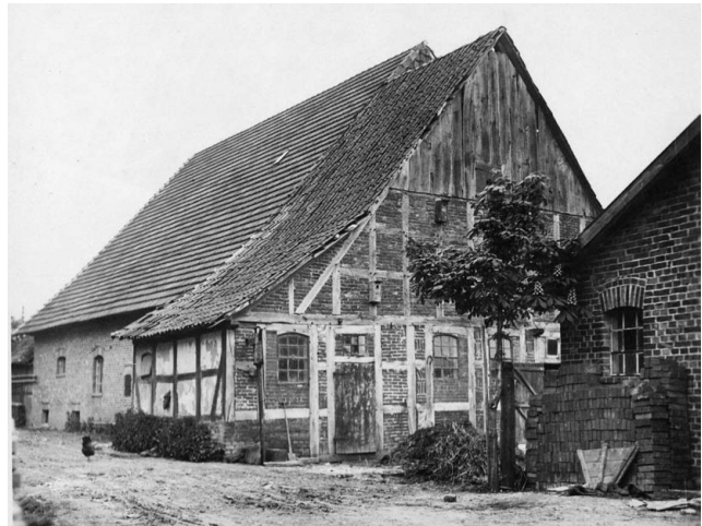
Das Geburtshaus Wilhelm Buschs vor der Sanierung, um 1927
