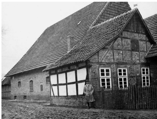
Das Geburtshaus Wilhelm Buschs nach der Sanierung. Am Zaun: Emil Conrad, um 1930
